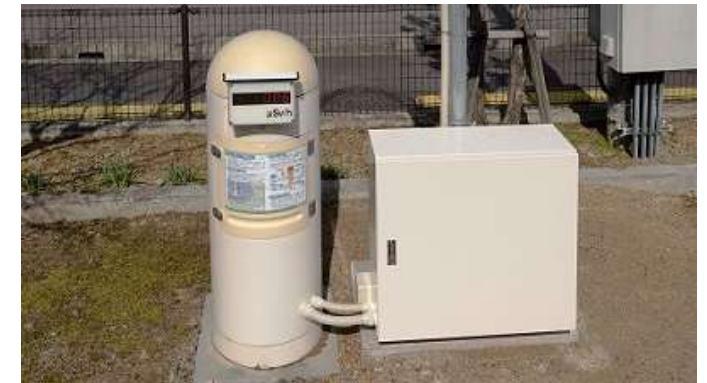
「福井原子力環境監視センター」
